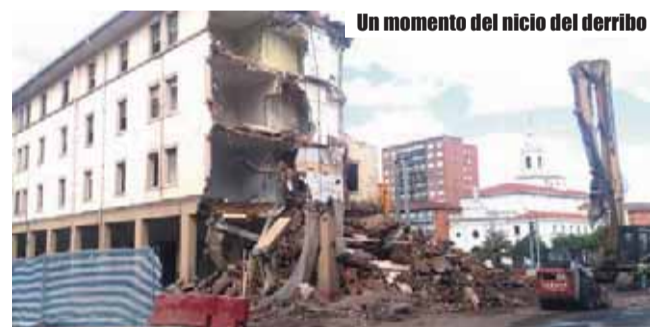
Un momento del nicio del derribo
